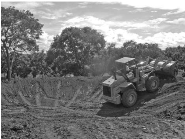
Construção de barragem, no Município de Formiga, em Minas Gerais.
